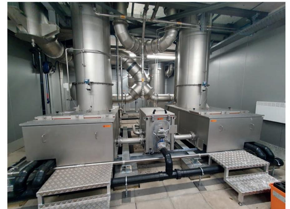
Die drei KMA-Gaswäscher kühlen, befeuchten und reinigen die Schokoladen-Abluft in Vorbereitung auf den Biofilter. (Bild: KMA)
